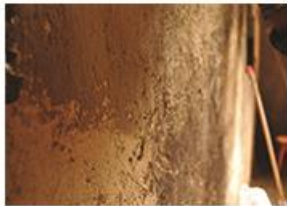
Fotografía: Muros de bareque .
