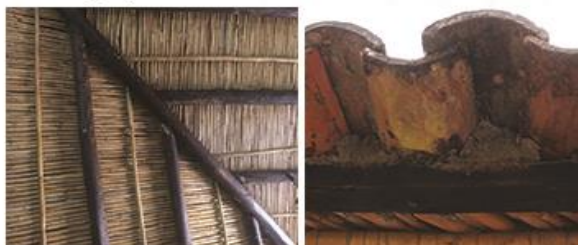
Fotografía: estructura de cubierta cocina. Fuente: propia
