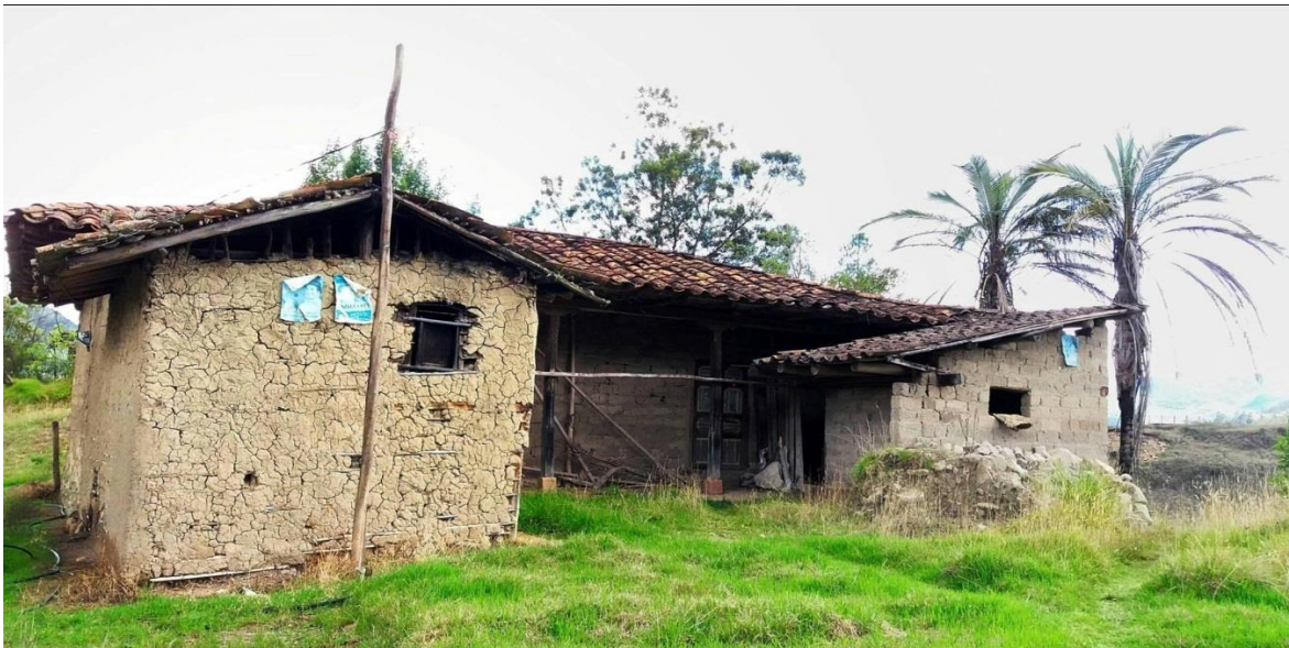
Fotografía 10: Vivienda tradicional con el sistema constructivo bahareque.
