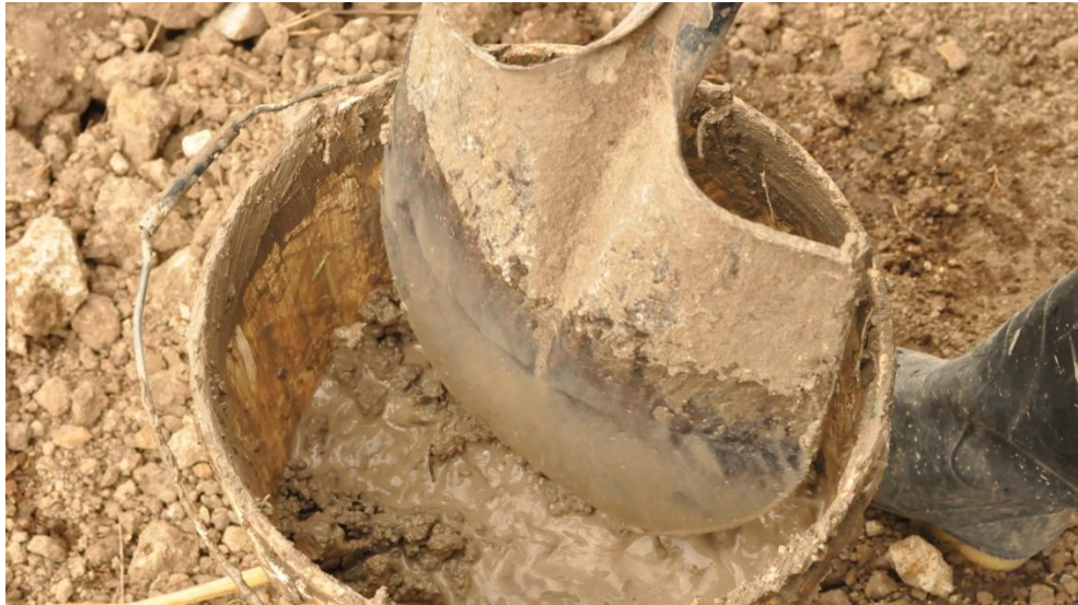
Fotografía 42: proceso de preparación de tierra para revocar.
