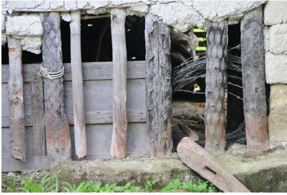
Fotografía 8: Sistema constructivo bahareque parado.
