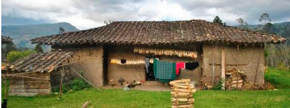
Fotografía 7: Vista frontal de la vivienda del pueblo Saraguro.
