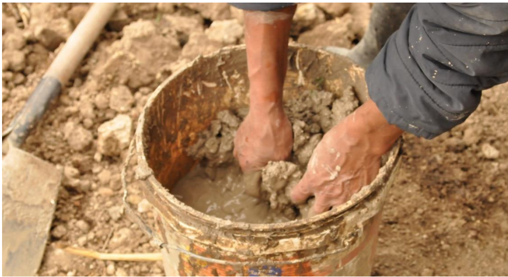
Fotografía 43: proceso y preparación de barro para revocar.
