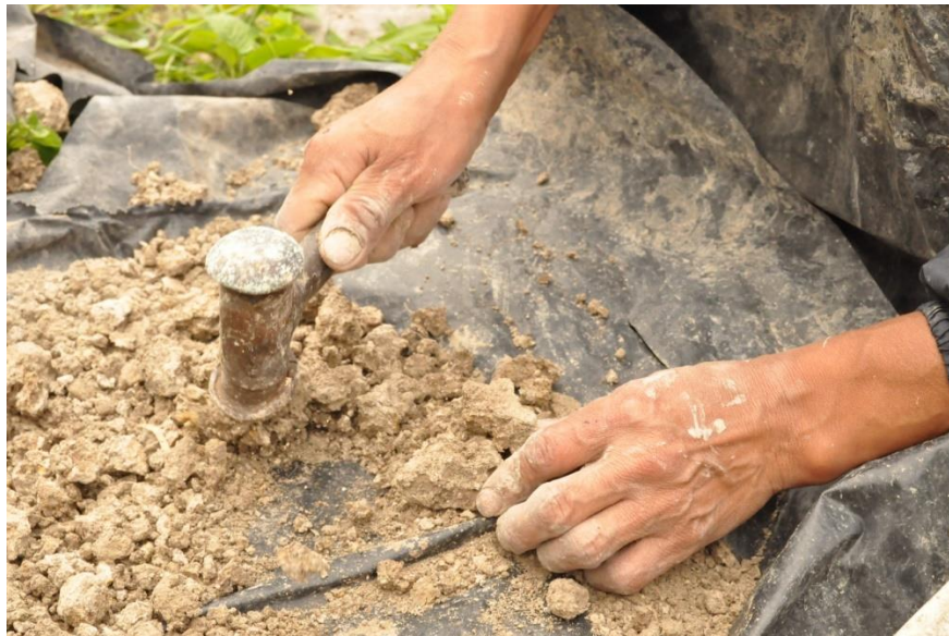
Fotografía 40: selección y preparación de tierra para revocar.
