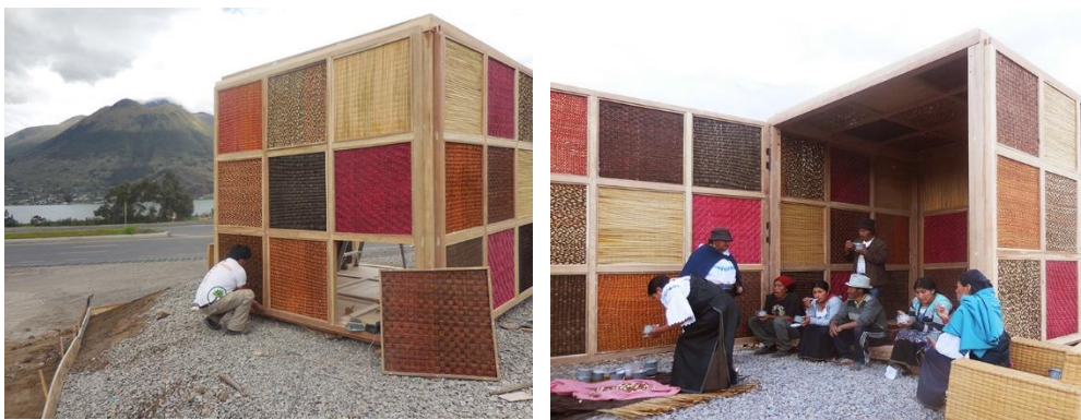
Fotografía 18: Elaboración del cubo de totora, San Rafael de la Laguna Otavalo.
