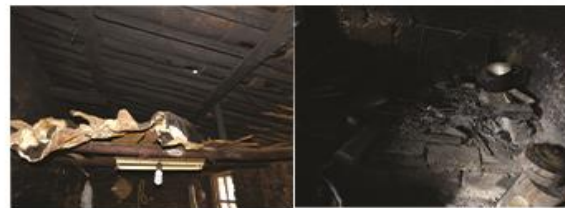
Fotografía: estructura de cubierta cocina.
