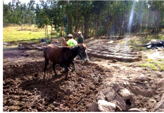
Fotografía 12: Preparación de la tierra para fabricación del adobe.
