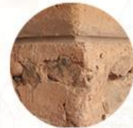
Cimiento de Piedra
