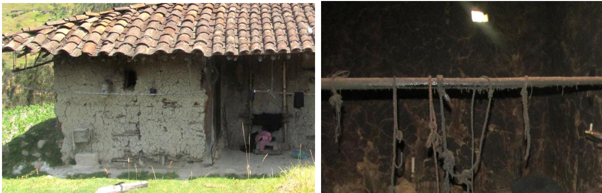
Fotografía 13: Vanos o hueco en la fachada oeste.
