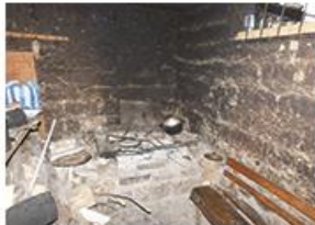
Fotografía: Muros de adobe.
