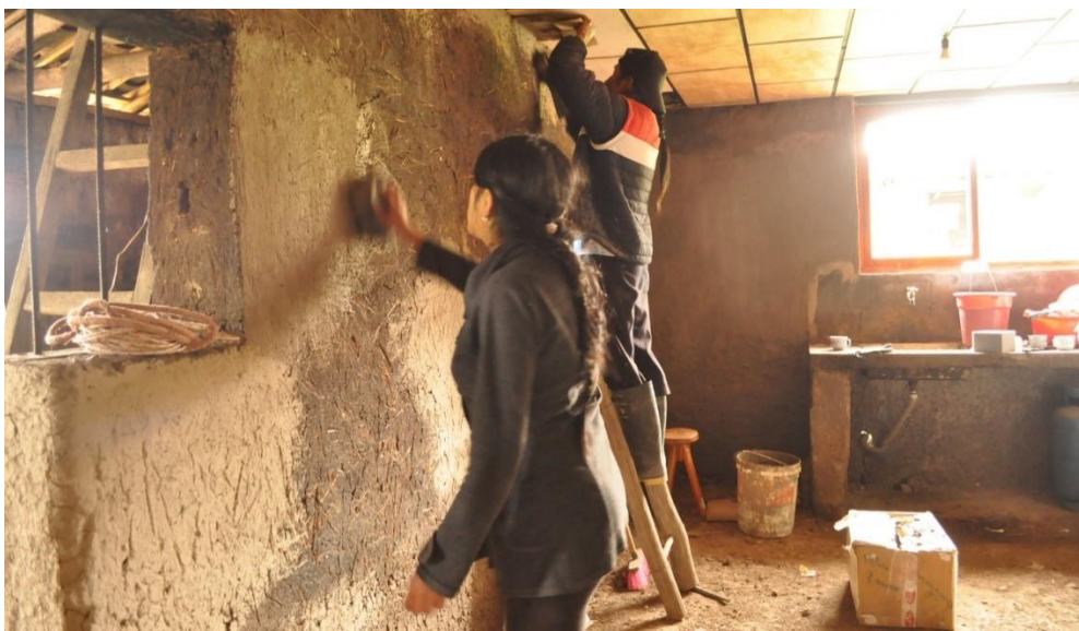
Fotografía 44: aplicación de pintura de tierra.
