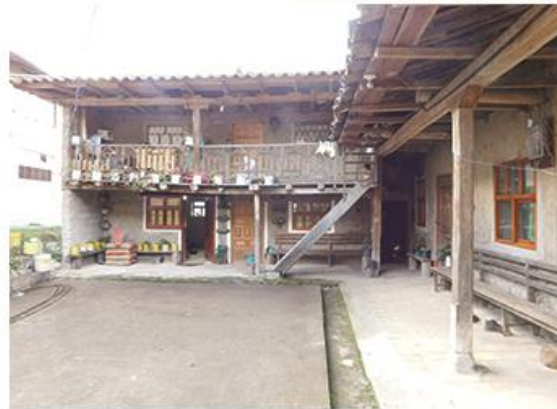
Fotografía: corredor espacios estado actual. (Ñamarin) Fuente: propia
