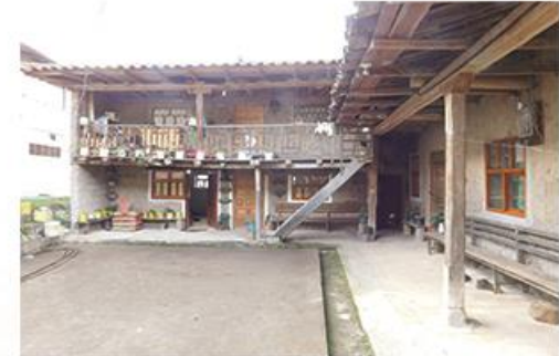
Fotografía: vivineda a intervenir. Fuente: propia
