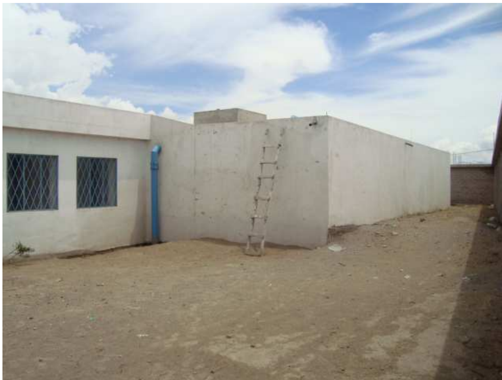
Fotografía N° 6: Tanque de almacenamiento de 1000 m3. Reserva El Recreo
