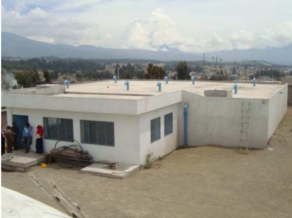
Fotografía N° 5: Tanque de almacenamiento de 1000 m3. Reserva El Recreo
