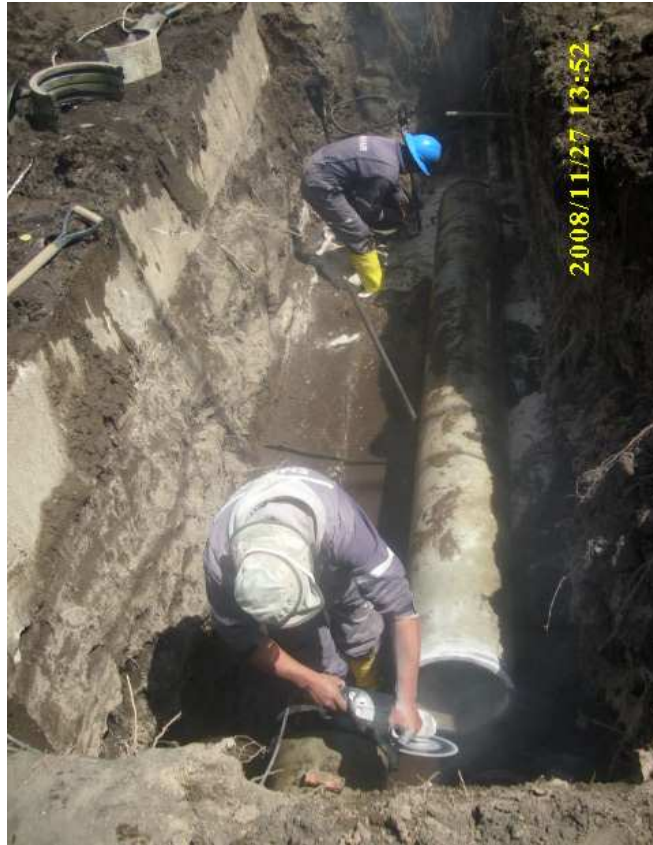
Fotografía N° 1: Arreglo en la conducción de asbesto-cemento
