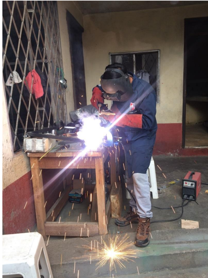
F3. Fabricación de la estructura.
