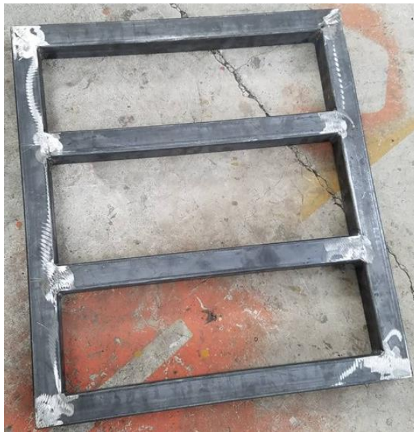
Figura 68: Construcción de la bancada
