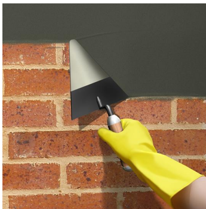
Figura 2: Proceso de revoco de paredes [2]
