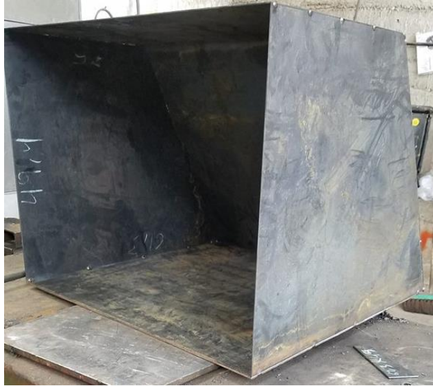
Figura 69: Construcción de la tolva de almacenamiento
