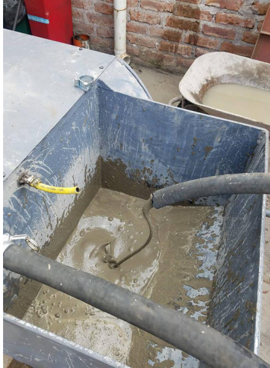
Figura 85: Prueba de la bomba peristáltica realizada con mortero de cemento 3:1
