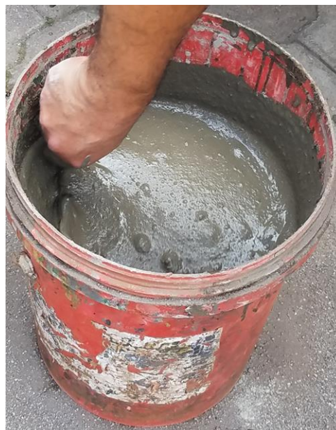
Figura 84: Preparación de la mezcla de mortero de cemento con proporciones 3:1 a bombear
