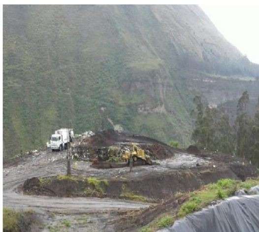
Figura 1. Vertedero antiguo del Cantón Baños de Agua Santa
