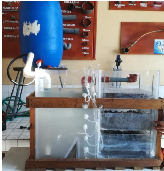
Figura16: Filtro separador de grasas y eliminador y eliminador de impurezas en funcionamiento. Fuente: Autor.
