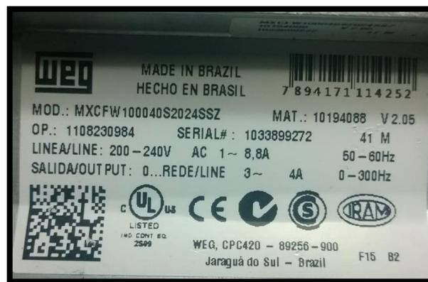
**Figura 41.** Placa del variador de frecuencia cfw 10 weg.
