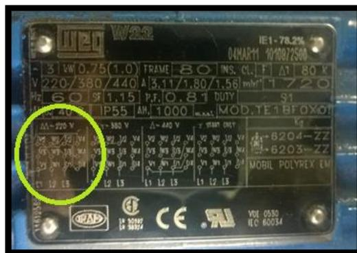
**Figura 53.** Tipo de conexión para bajo voltaje 220V.
