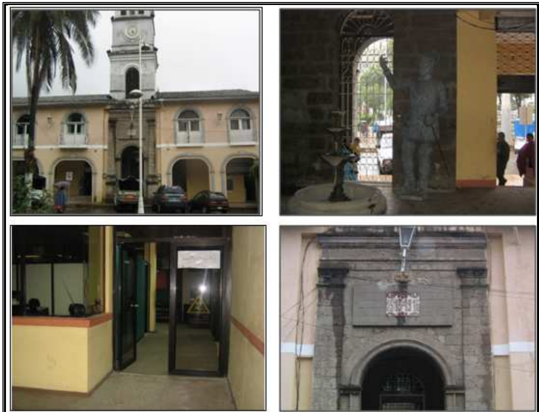
Fig. 6.1 Infraestructura del Ilustre Municipio de Chimbo
