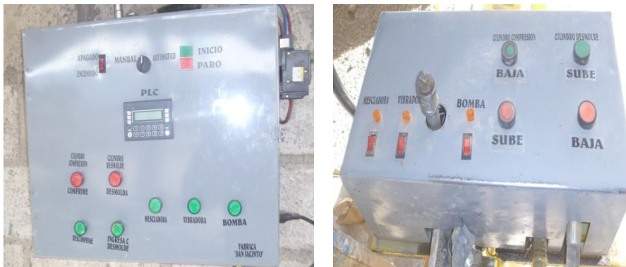
Figura 126. Pintado y etiquetado de paneles de control
