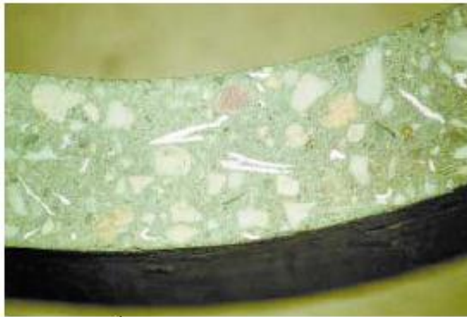
Bild 9. Schnitt durch ein Rohr aus Hochleistungsfaserbeton – Teilansicht Fig. 9. Section through a pipe made of high-performance fibre concrete – partial view
