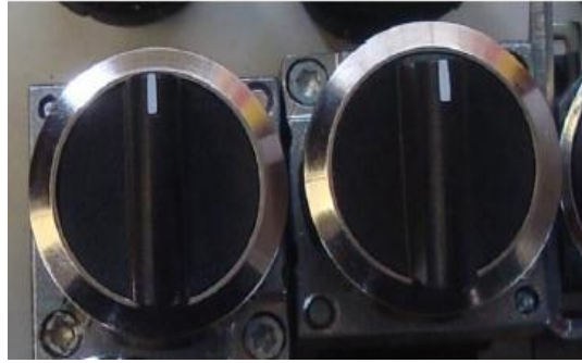
Figura 69. Selector de 3 posiciones
