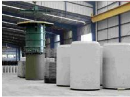
Figura 6. Desmolde de tubos
