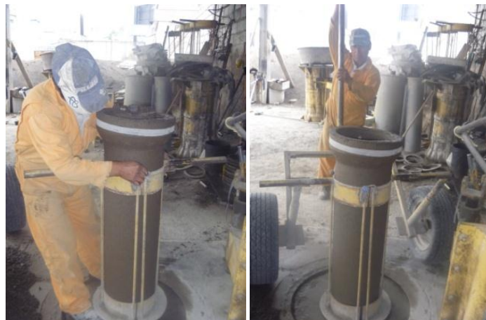
Figura 15. Colocación en la canastilla de transportación y previa transportación
