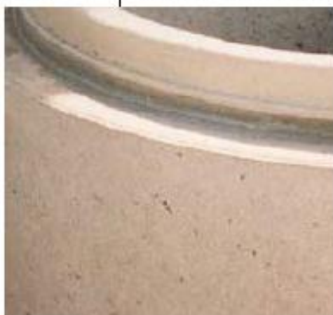
Bild 10. Betonelement vor Umbau des Fertigers Fig. 10. Concrete element before modification of the finishing machine
