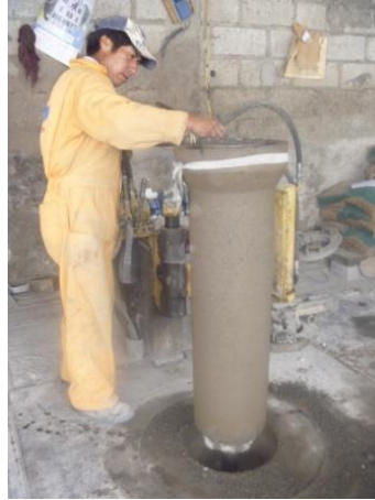
Figura 14. Desmolde de tubo
