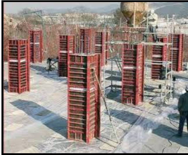
Gráfico N° 16: Encofrados.
