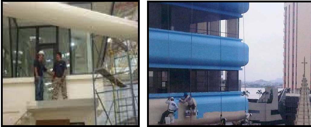
Gráfico N° 19: Trabajos en Altura.
