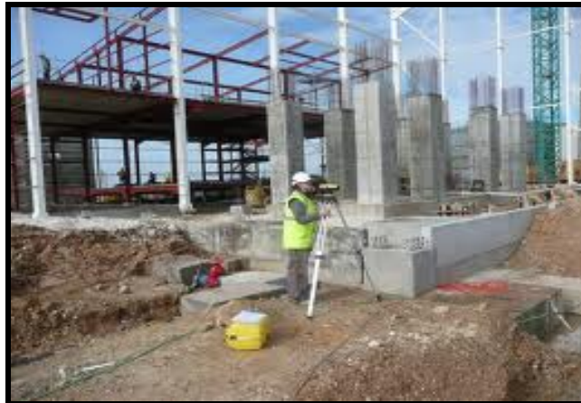
Gráfica N° 11: Replanteo y Nivelación.
