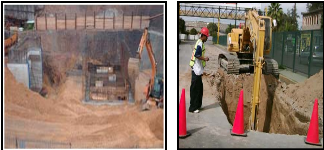
Gráfica N° 38: Señalización en Excavaciones.
