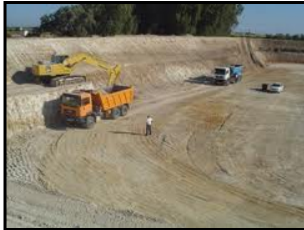
Gráfica N° 12: Excavaciones y Movimiento de Tierras.
