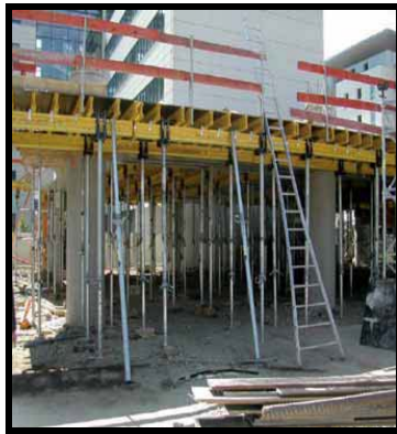
Gráfica N° 44: Medidas de Protección en Alturas.
