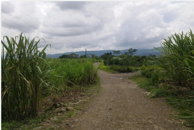
Calzada lastrada con un ancho promedio de 4m y 5m.
