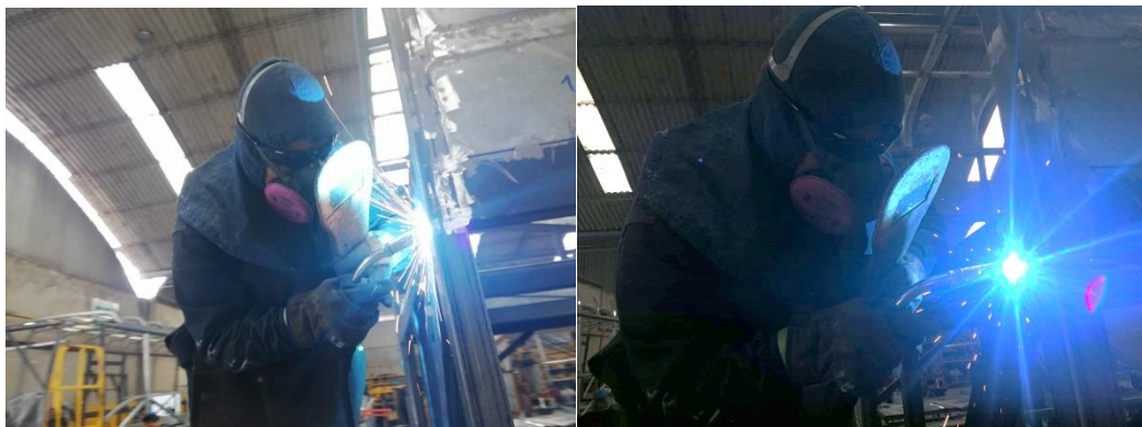
Ilustración 8. Soldadura de perfiles de acero con proceso GMAW
