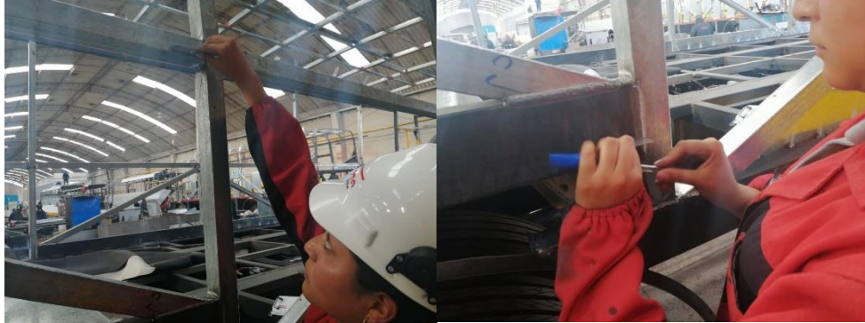
Ilustración 9. Inspección de las soldaduras en la estructura
