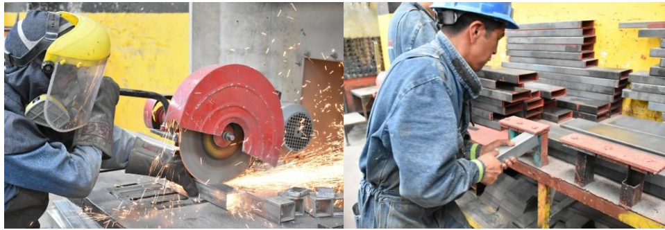
Ilustración 4. Corte de perfiles de acero y dobladora de perfiles
