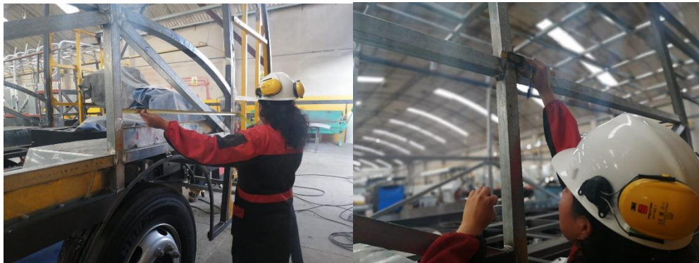
Ilustración 5. Verificación de medidas por parte del supervisor
