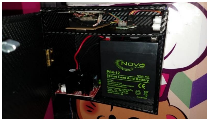
Figura 4.52 Estructura externa instalada en un costado del frigorífico
