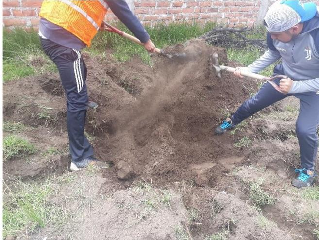
Figura 26. Excavación del pozo a cielo abierto
