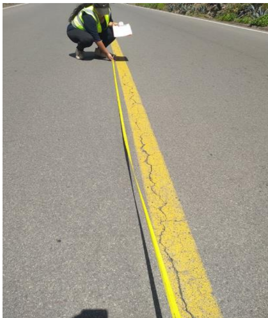
7. Fisura longitudinal
