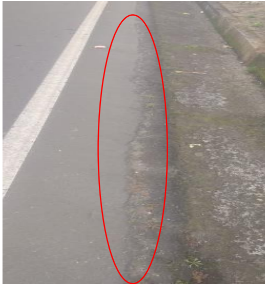
7. Fisura longitudinal
