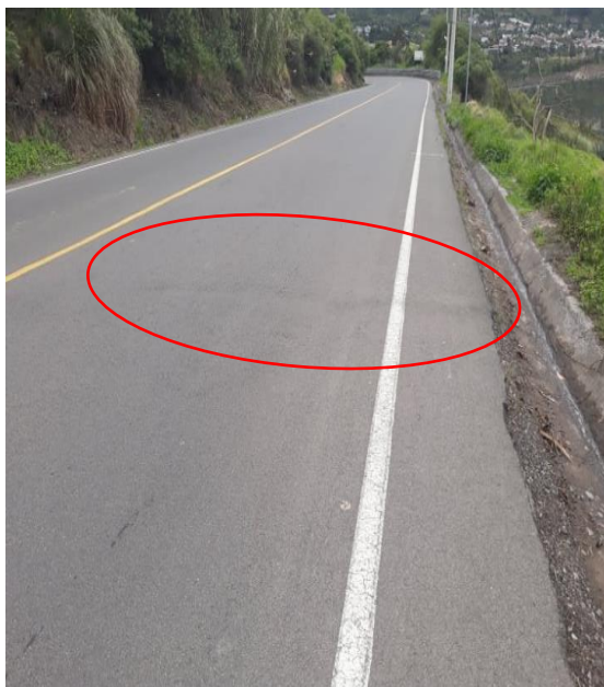
3. Abultamiento y Hundimiento
