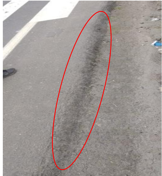
8. Fisura transversal
