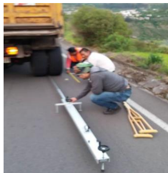
Figura 4. 6: Posicionamiento de la viga Benkelman
