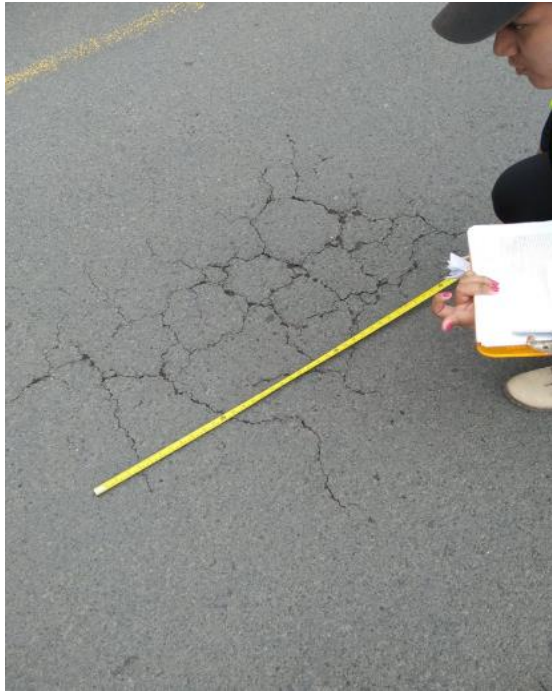
3. Abultamiento y Hundimiento
