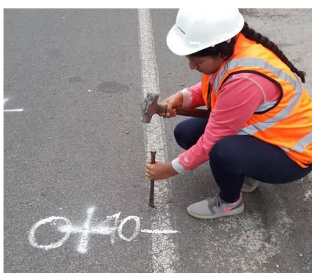
Figura 4. 7: Perforación para previa lectura de la temperatura
