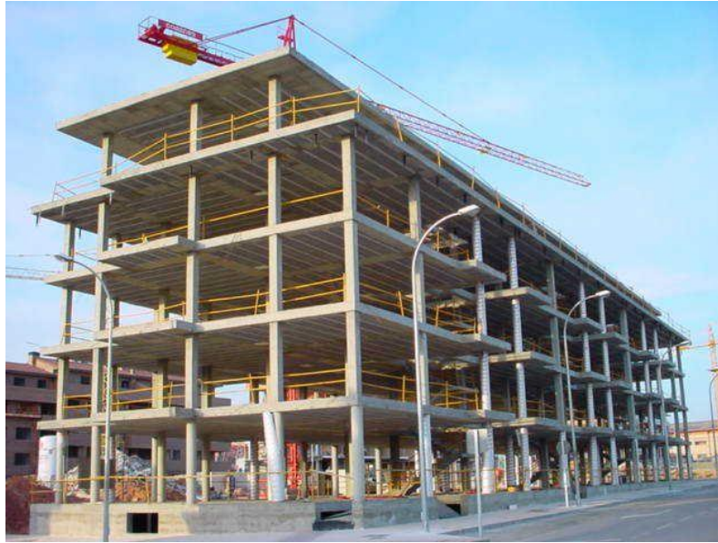
Ilustración 19. Sistema estructural aporricado de hormigón armado
