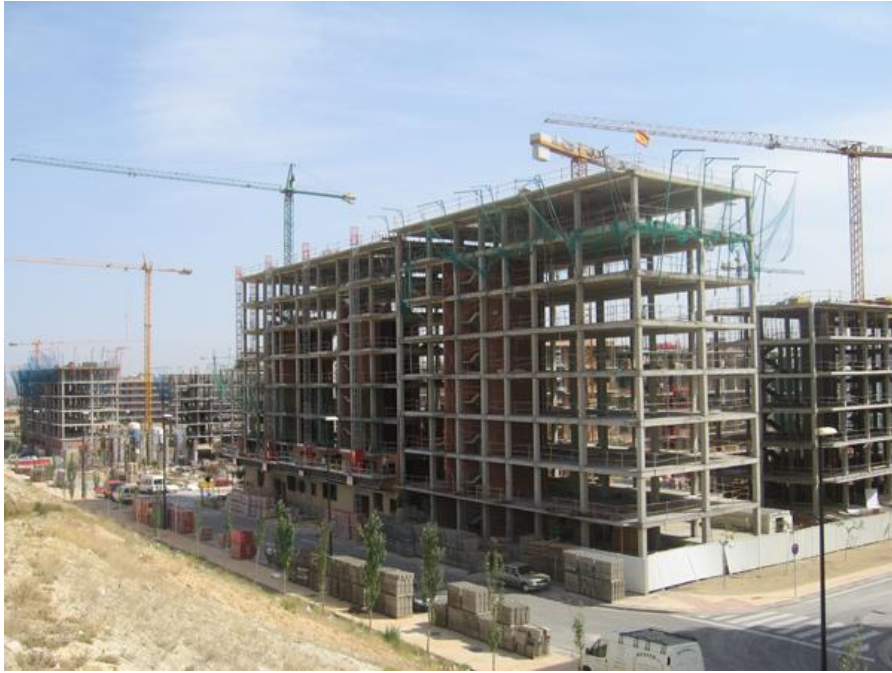
Ilustración 21. Sistema estructural dual.
