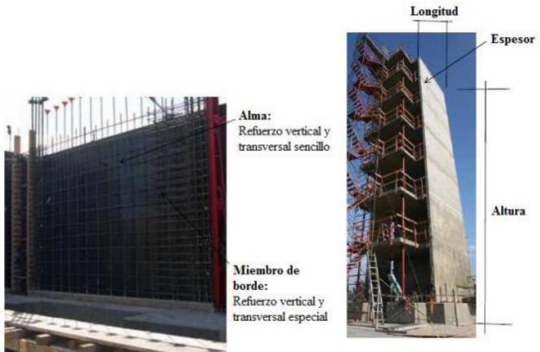
Ilustración 20. Partes de un muro rectangular simple.
