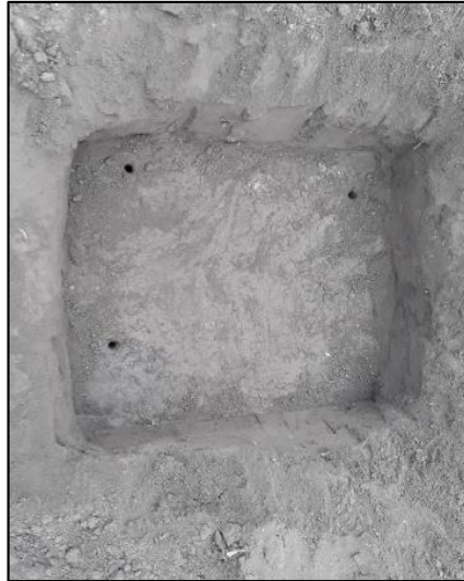
Figura 18. Pozo a cielo abierto
