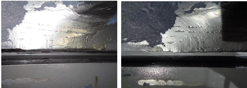
Figura 6.3 Pulido y lijado para la aplicación de la Belzona.
