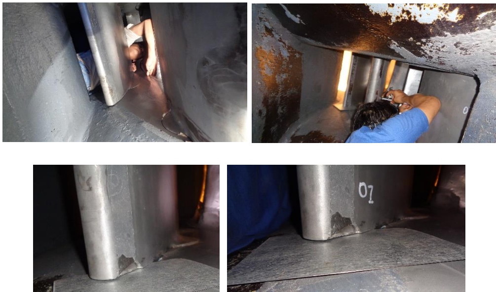
Figura 6.2 Inspección de campo de los álabes directrices.
