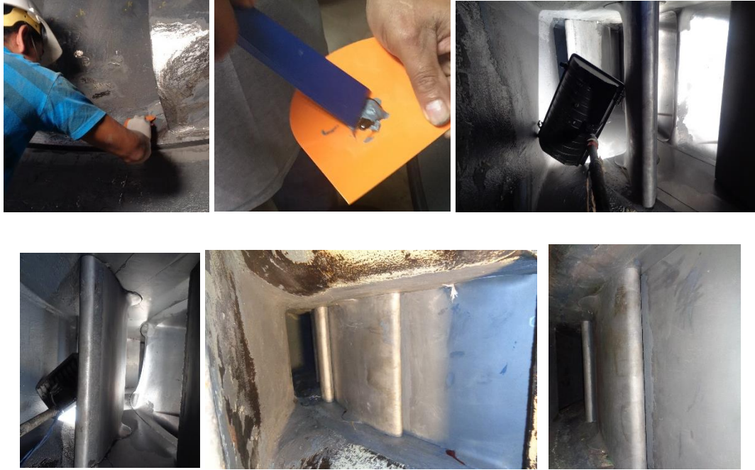
Figura 6.4 Aplicación del recubrimiento en el álabe directriz.
