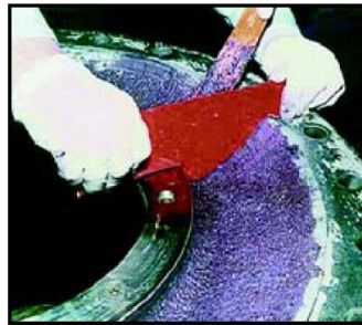
Figura 2.8 Aplicación de la Belzona [16].
