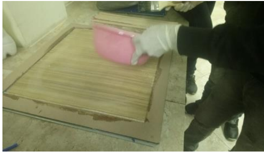
Figura 1.70: Esparcir la resina epoxi sobre el tejido
