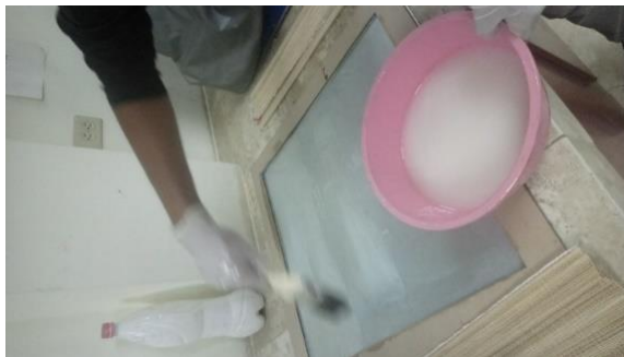
Figura 1.68: Primera capa de resina sobre la superficie
