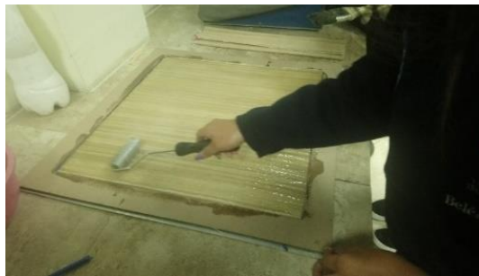
Figura 1.71: Deslizar el rodillo para fibra por el tejido
