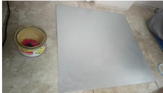
Figura 1.55: Plancha de tol adherida a la superficie
