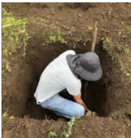
Figura 25. Excavación del Pozo a Cielo Abierto
