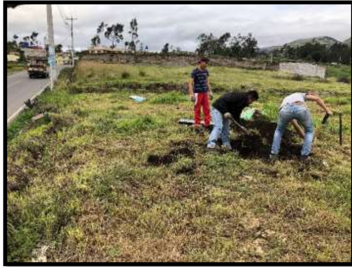
Figura 83. Excavación del pozo de 1 m 3 aledaño a la vía de análisis
