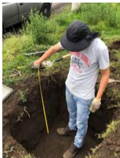
Figura 26. Medición de 1 m de profundidad de Pozo a Cielo Abierto
