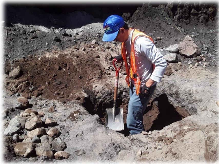
Figura 19. Excavación manual de pozos a cielo abierto
