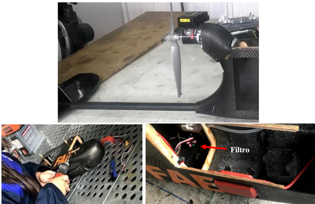
Fig. 74 Ubicación de Motor y ESC en fuselaje.
