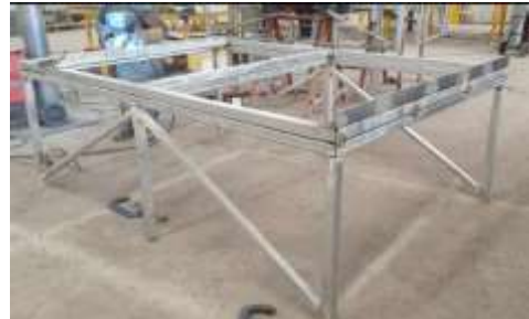
Construcción de plataforma
