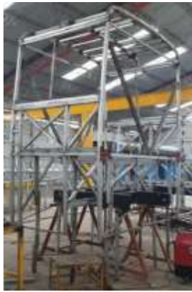
Ensamblaje de techo
