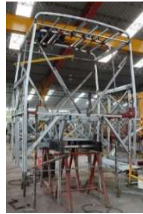
Ensamblaje de techo
