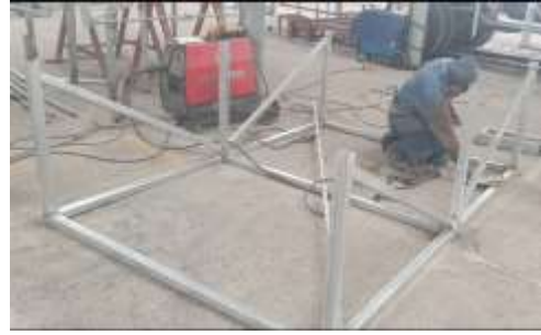
Construcción de plataforma
