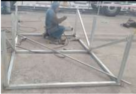
Construcción de plataforma
