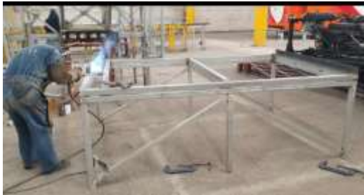
Construcción de plataforma
