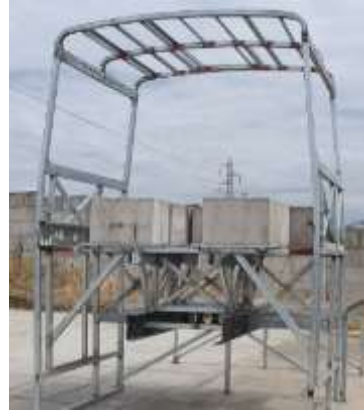
Colocacion de masas equivalentes sobre estructura
