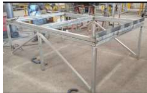
Construcción de plataforma
