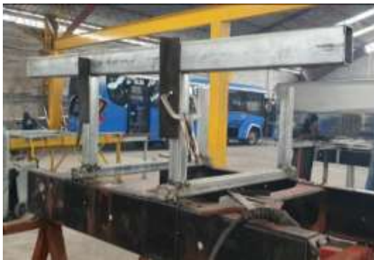
Construcción de Anclajes
