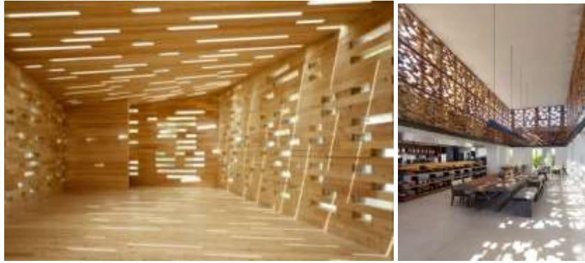
Imagen 22. Pabellón de la Universidad de Tokyo por Kohki Hiranuma Architect & Associates realizado con desperdicios de madera de cedro en listones de diferentes secciones.
