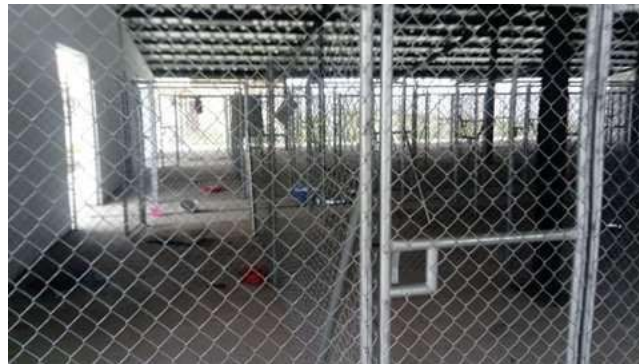
Ilustración 38. Área instalaciones caniles
