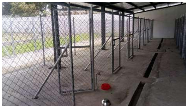
Ilustración 47. Humedad en caniles
