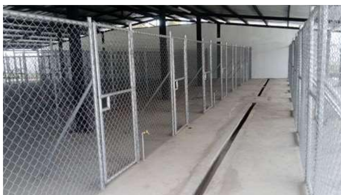
Ilustración 40. Área instalaciones caniles
