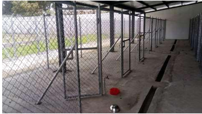
Ilustración 37. Área instalaciones caniles
