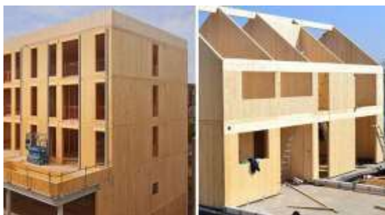
Ilustración 8. Construcción con madera contralaminada Fuente: ( https://maderame.com/construcciones-madera/ )
