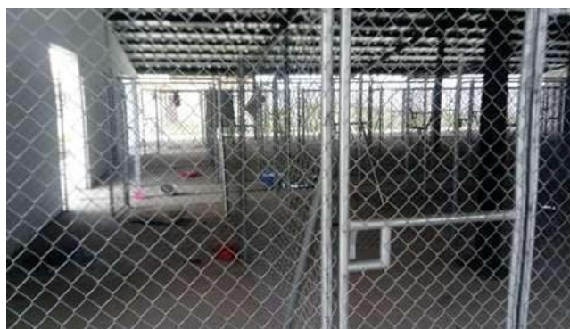
Ilustración 48. Humedad en caniles
