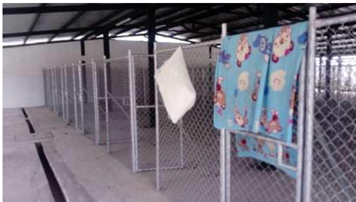
Ilustración 39. Área instalaciones caniles
