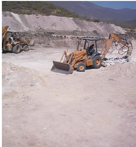
FIGURA 3.2 EXCAVACIÓN DE ZANJAS
