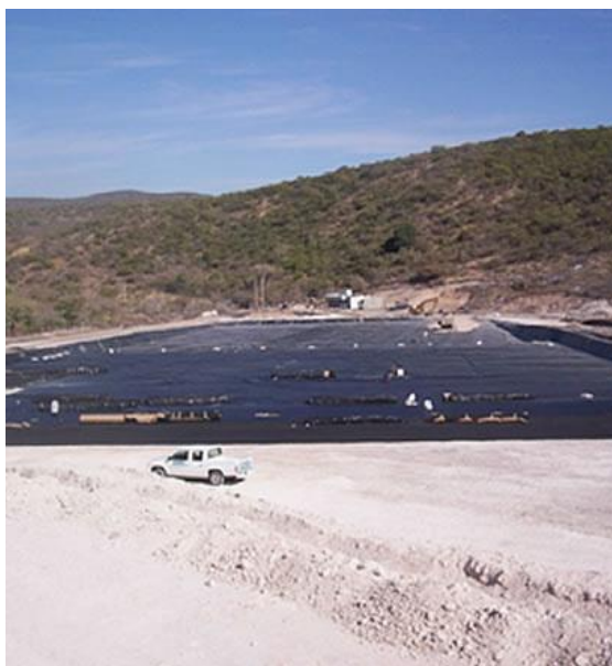
FIGURA 3.4 COLOCACIÓN DE GEOTEXTIL Y GEOMENBRANA
