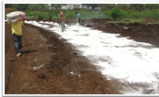
GRÁFICO 9. Compactación mediante aditivos químicos
