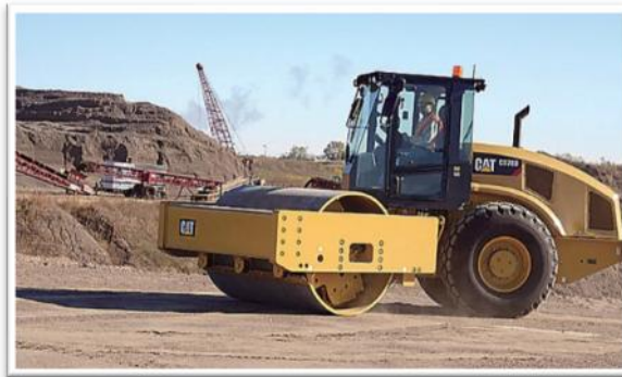
GRÁFICO 7. Compactación mediante maquinaria
