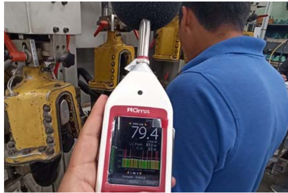
Figura 14 Medición de ruido ambiental
