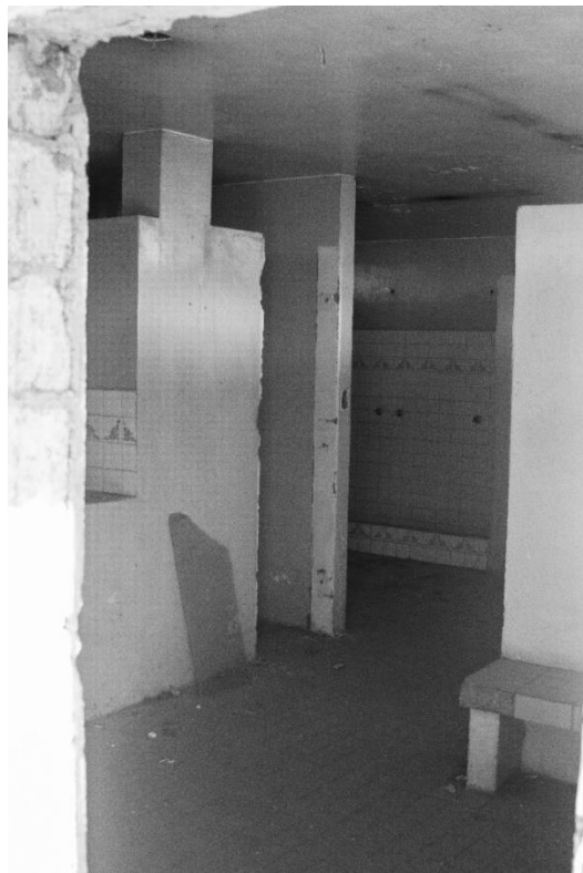
Fotografía 11. Interior del complejo deportivo acuático de la Federación Deportiva de Tungurahua.
