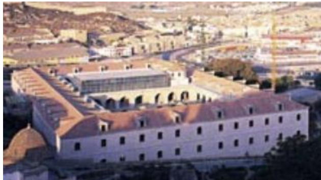
Gráfico 30. Luz natural mediante sistema de patios.
