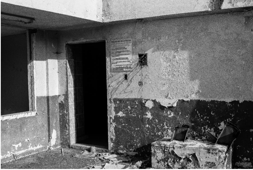
Fotografía 10. Interior del complejo deportivo acuático de la Federación Deportiva de Tungurahua.
