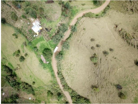
Anexo 29B. Estado de la vía actual tomada desde el dron a una altura de 180 metros
