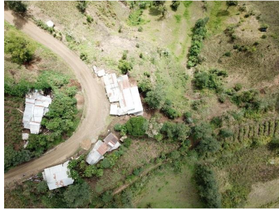
Anexo 30B. Estado de la vía actual tomada desde el dron a una altura de 150 metros
