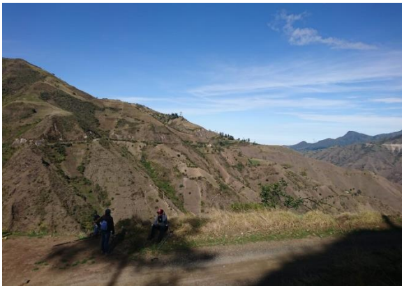
Anexo 3B. Estado de la vía actual
