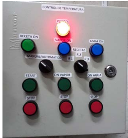
Figura. 6.11 Instalación de mandos de operación y etiquetado.
