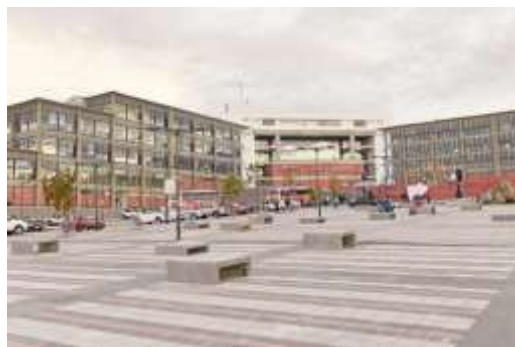
Imagen 48 Explanada del Municipio de Ambato
