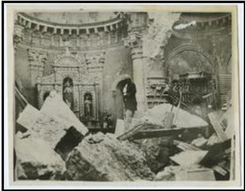
Figura 16. Daños de la Catedral de Ambato el 5 de agosto de 1949
