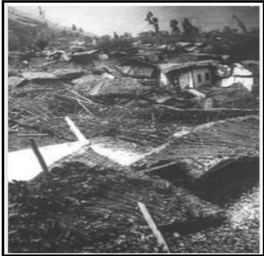
Figura 15. Viviendas de adobe colapsadas el 5 de agosto de 1949
