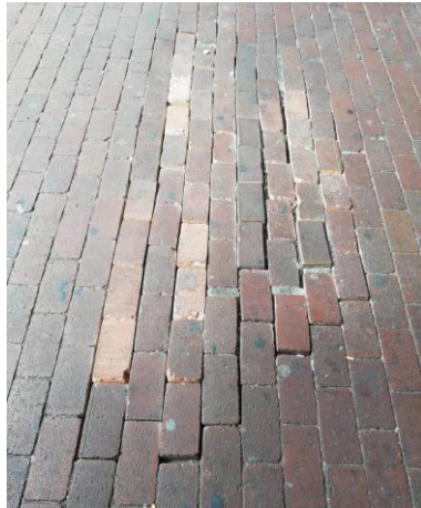
Adoquines levantados
