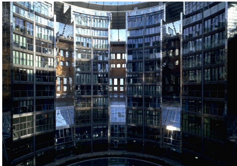
Ilustración 18. Interior del Gasómetro A. Fuente. Jeannouvel.com (2020).
