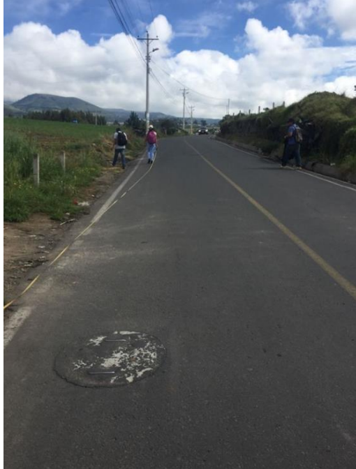
Descripción: Marcación de abscisas en la vía Ambato - Tisaleo, en el tramo 9+600 hasta 12+800
