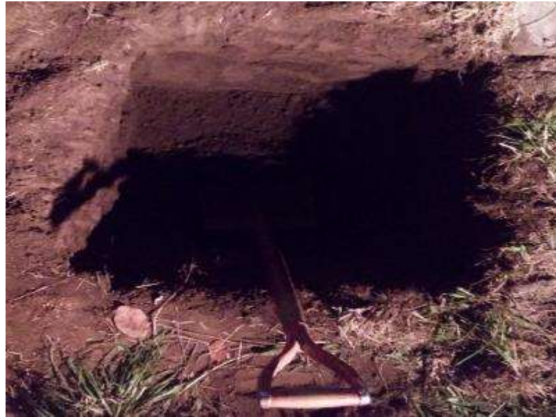
Fotografía 1 Cavado del hoyo en la tierra.
