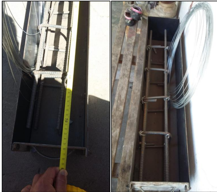
Figura 13. Preparación de encofrados metálicos Fuente: Nelson Chugchilan
