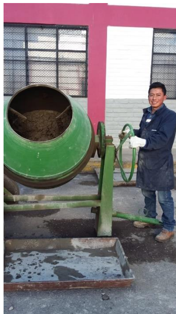
Figura 9. Fundición del hormigón en la concretera
