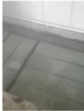
Figura 16. Curado de las vigas Fuente: Nelson Chugchilan
