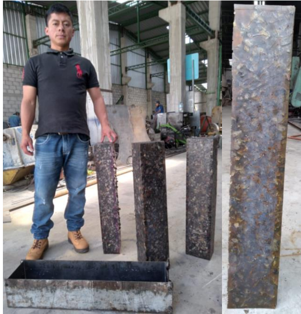
Figura 26. Desencofrado de vigas. Fuente: Nelson Chugchilan
