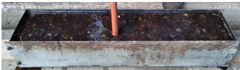
Figura 25. Fundición de vigas de hormigón polimérico Fuente: Nelson Chugchilan
