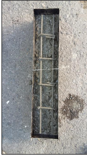
Figura 14. Colocación del hormigón en la viga Fuente: Nelson Chugchilan
