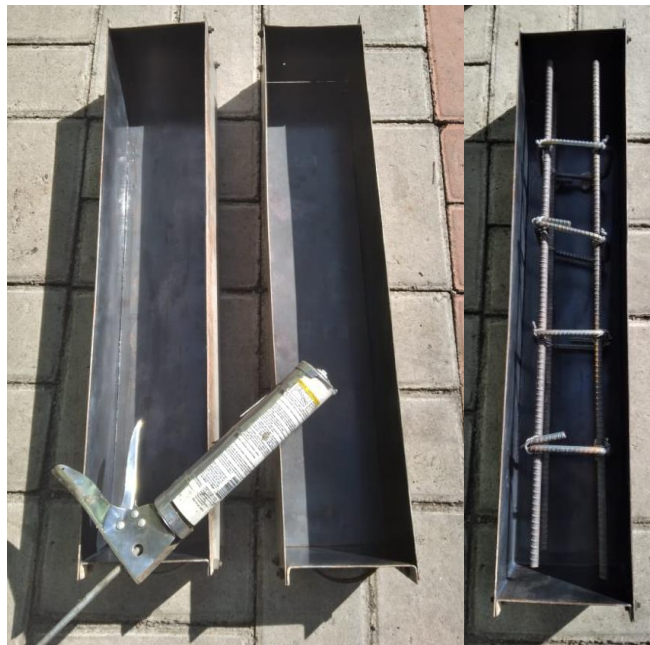
Figura 23. Preparación de encofrados metálicos Fuente: Nelson Chugchilan
