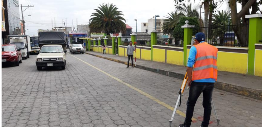
FIGURA 5. Levantamiento topográfico de la vía con estación total
