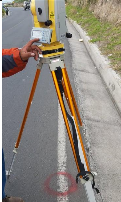
Estación total plantada
