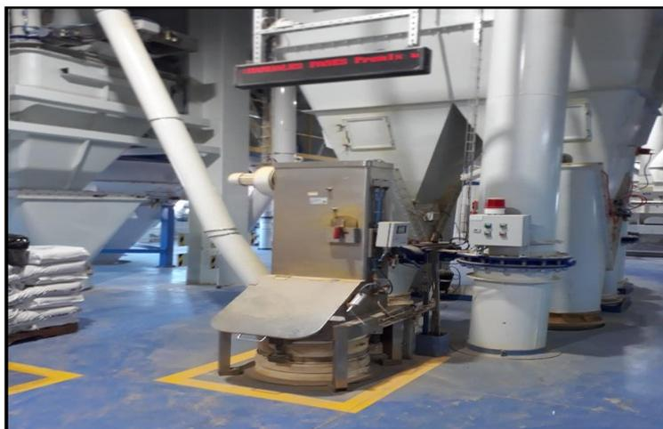
**Figura 16:** Ducto de tolva de ingreso de micro ingredientes manuales
