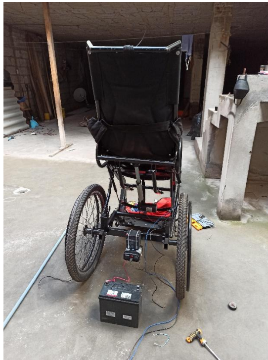
Figura 55: Colocación del actuador lineal, inversor de voltaje y batería.
