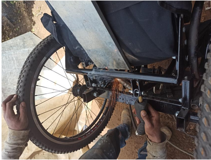
Figura 52: Soldado del eje secundario.
