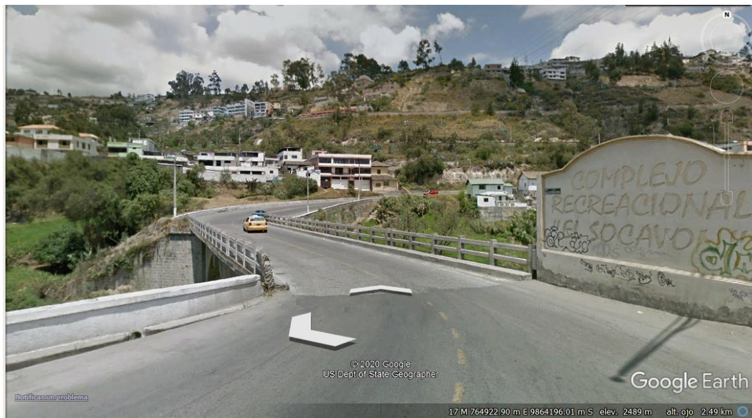
Figura N°27. Puente Sector el Socavón
