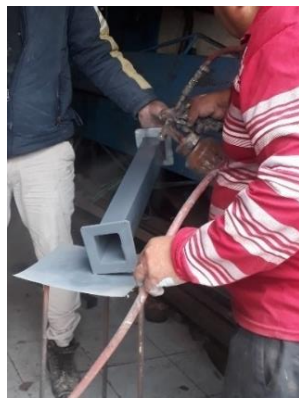
Figura 3. 8 Construcción accesorios - Cuarta etapa. [Autor]
