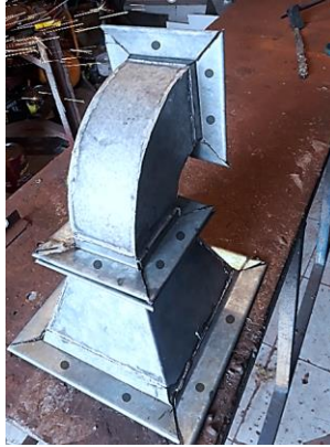
Figura 3. 7 Construcción accesorios - Tercera etapa. [Autor]
