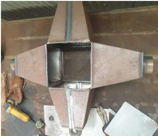
Figura 3.15 Construcción estructura de las transiciones [Autor]
