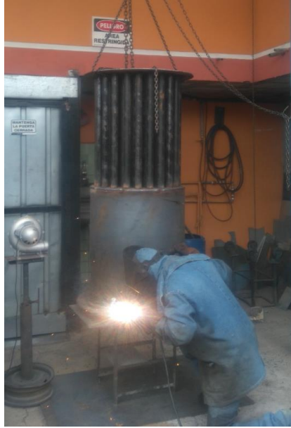
Figura 25. Soldadura de rodela de cierre contra cámara de fuego
