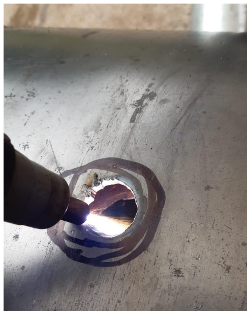
Figura 28. Elaboración de agujeros para colocación de neplos y visor en cuerpo de la caldera
