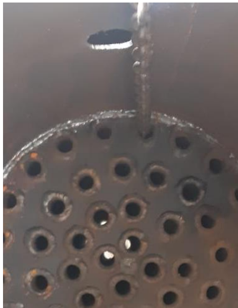
Figura 26. Soldadura de espejo inferior de haz tubular contra cámara de fuego
