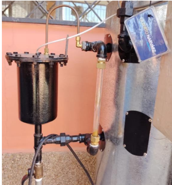
Figura 37. McDonnell y visor de nivel
