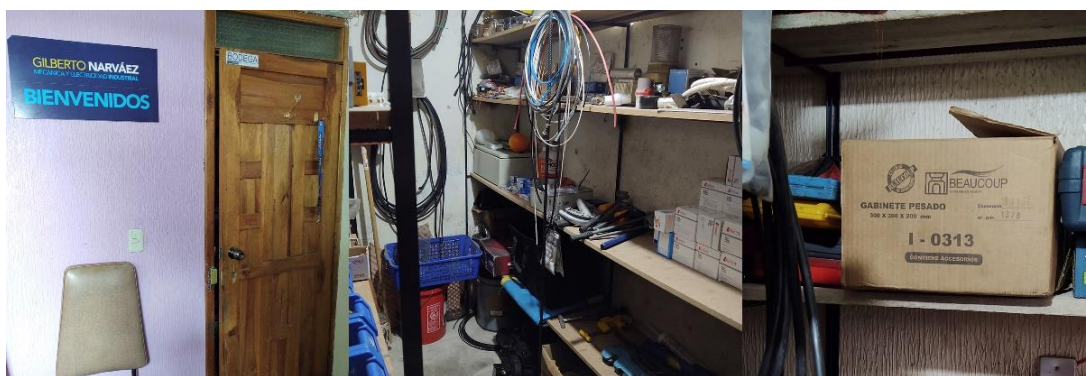
Figura 60. Almacenamiento gabinetes eléctricos (proceso actual)
