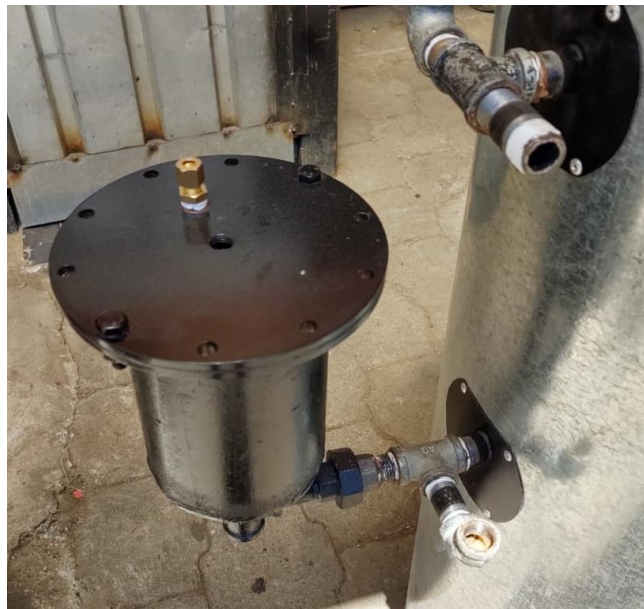
Figura 36. McDonnell y accesorios para fijar visor de nivel
