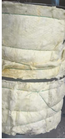
Figura 33. Colocación de lana de vidrio sobre estructura de caldera
