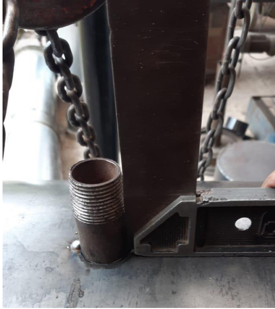
Figura 29. Colocación y escuadrado de nepllos en cuerpo de la caldera
