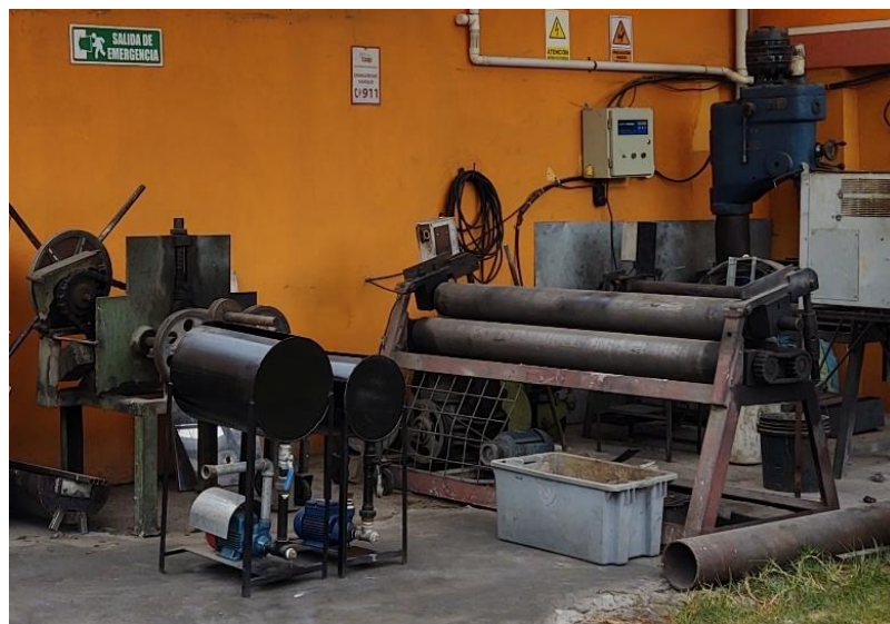
Figura 63. Almacenamiento tanques de abastecimiento (proceso mejorado)
