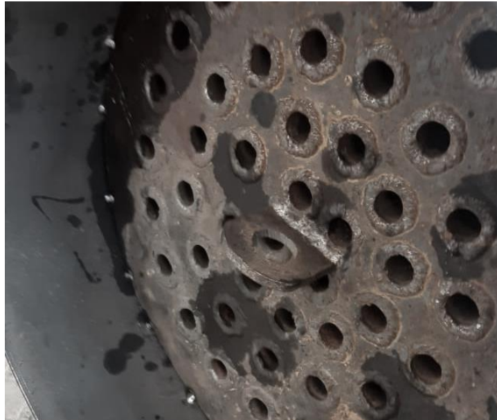
Figura 27. Cuerpo de la caldera acoplado a haz tubular, cámara de fuego y rodela de cierre
