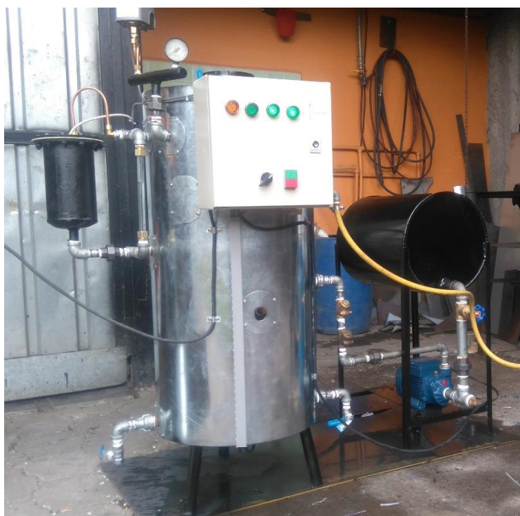
Figura 49. Instalación de tanque de abastecimiento y prueba del sistema
