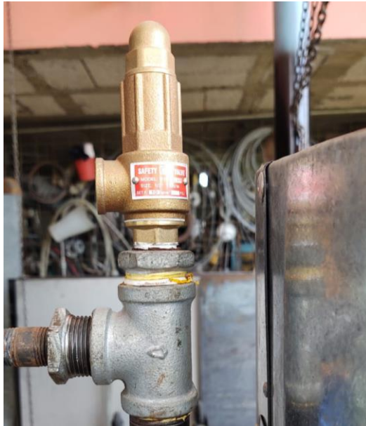
Figura 42. Válvula de alivio para caldera
