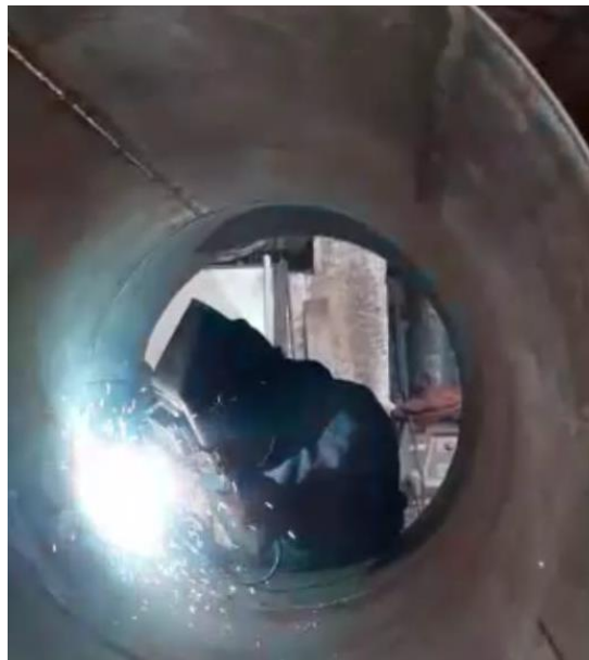
Figura 22. Proceso final de soldadura de cuerpo de la caldera
