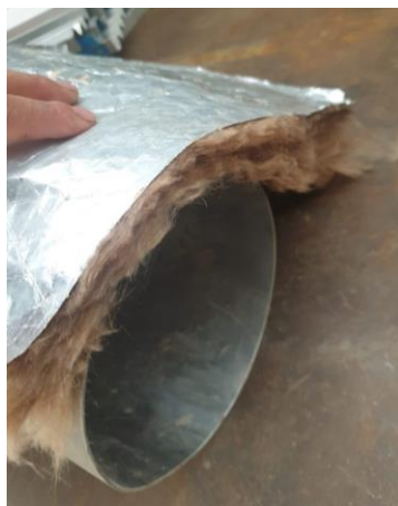
Figura 28.- Colocación del aislante [Autor]
