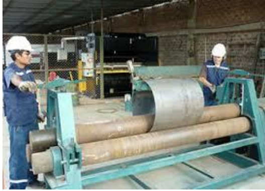
Figura 25.- Enrolado para construir el ducto [Autor]
