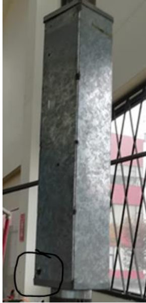
Figura 32.- Perforaciones para el fluido [Autor]
