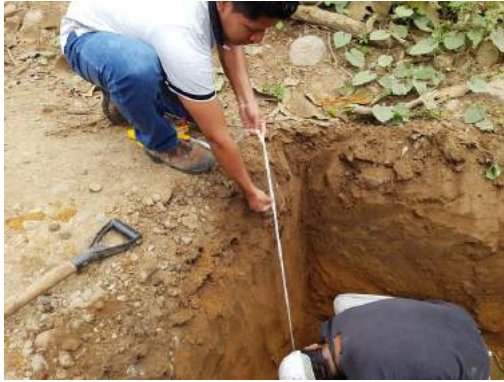
Fotografía 8: Mediciones de Subrasante y Sub base
