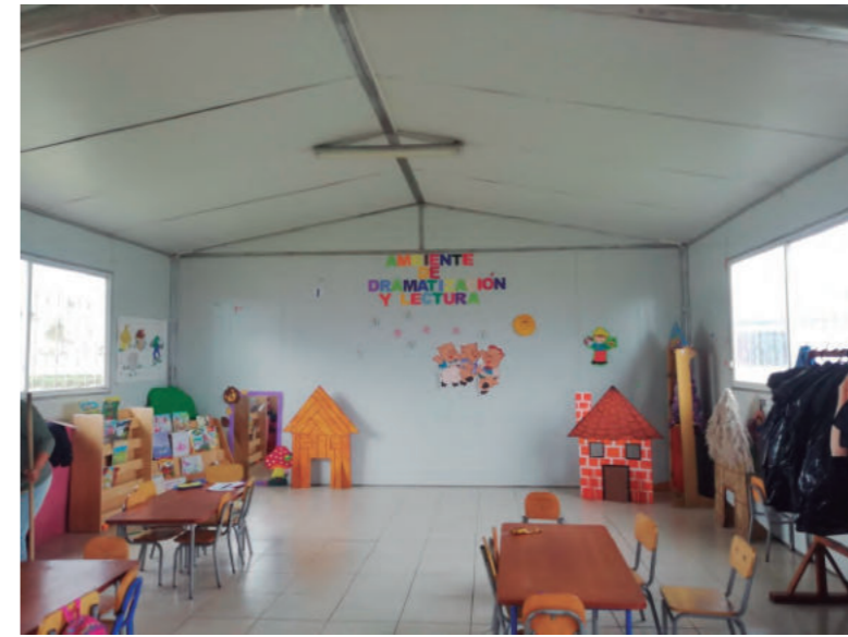
-Ventilación cruzada debido a la existencia de puertas y ventanas. (Aulas 1-8) - Inexistencia de cortinas (Aulas 1, 2, 3, 5, 6, 7, 8)
