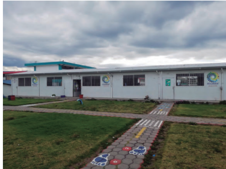
La estructura Steel Framing funciona como aislante térmico y acústico. (Aulas 1 - 8)
