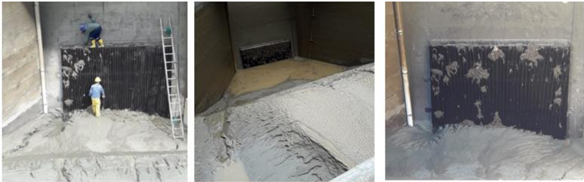
Figura 42. Limpieza de tanque de carga por personal civil.
