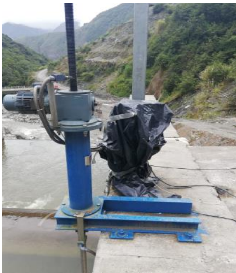
Figura 21. Toma lateral de estructura de apertura para la compuerta de la escalera de peces.
