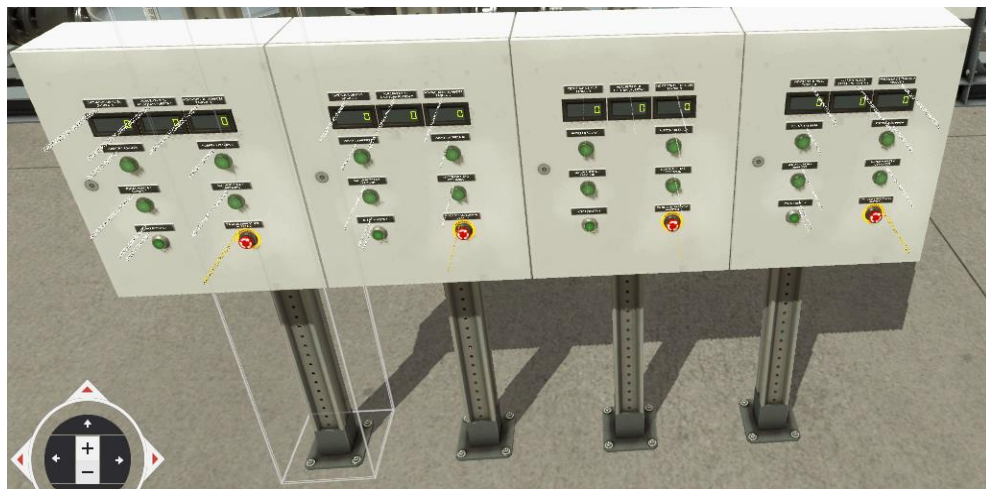
Figura 92. Mandos de las compuertas.
