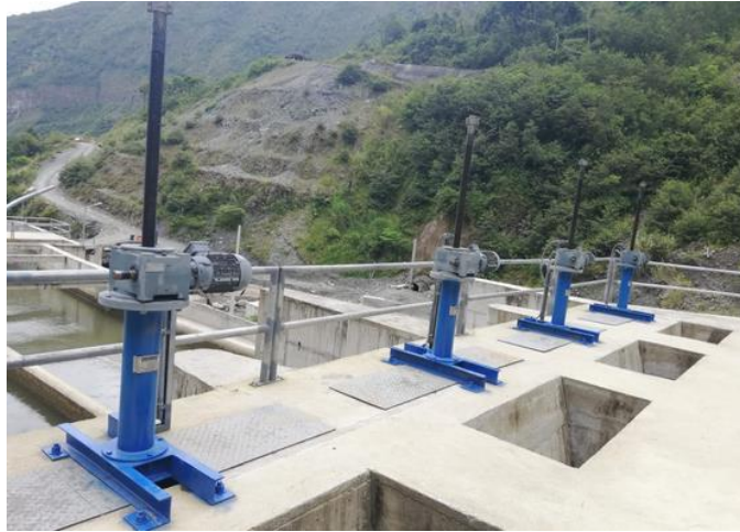
Figura 28. Estructura para la apertura y cierre de compuertas de entrada a las cámaras desarenadoras.
