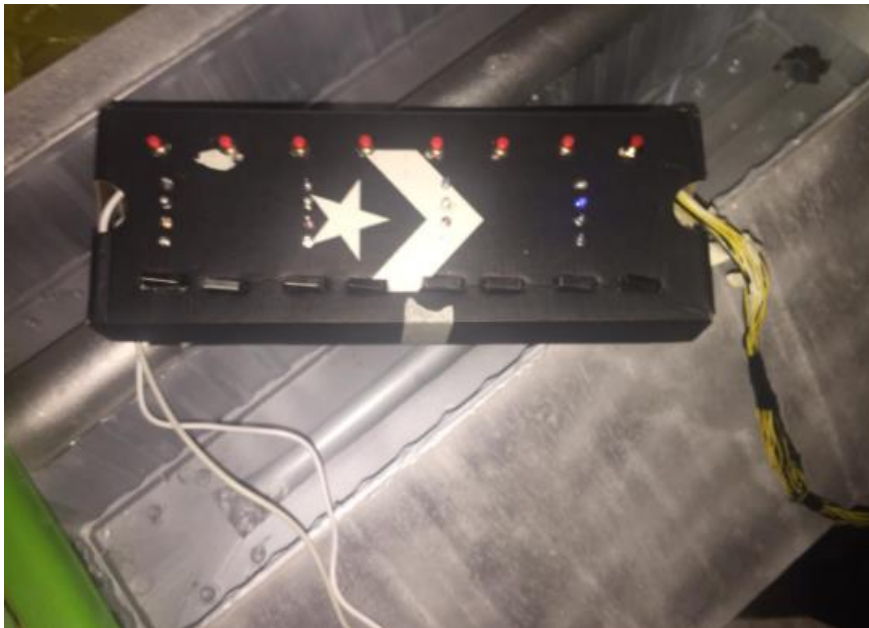
Figura 109. Mando de control y monitoreo de compuertas de purga.
