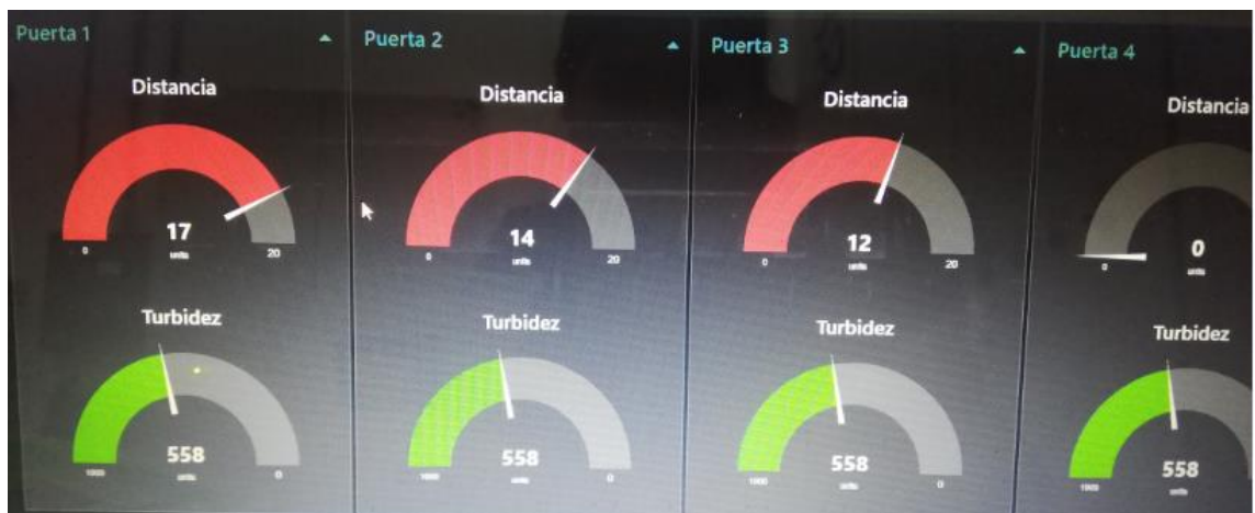
Figura 118. Tanque 1, 2, 3, con buen nivel de agua y turbidez alta y compuerta 4 con bajo nivel de agua y turbidez alta.
