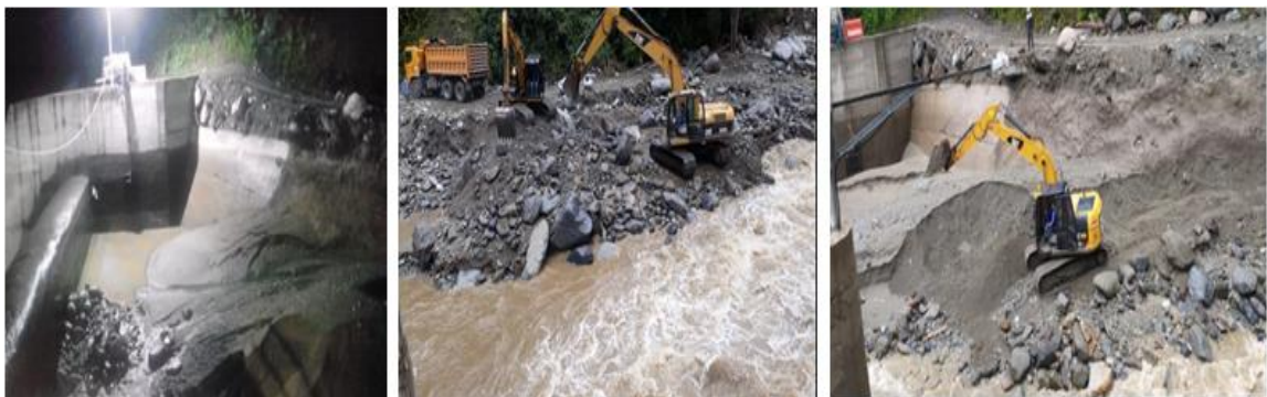
Figura 48. Limpieza de embalse y desalojo de rocas.
