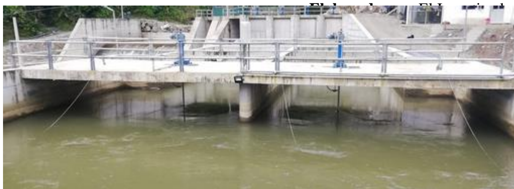
Figura 32. Vista panorámica de ubicación de compuertas de purgas de cámaras desarenadoras.
