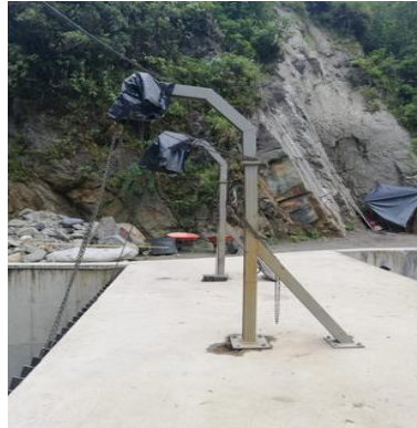
Figura 24. Tecles cubiertos utilizados para remoción de rejillas de limpieza.
