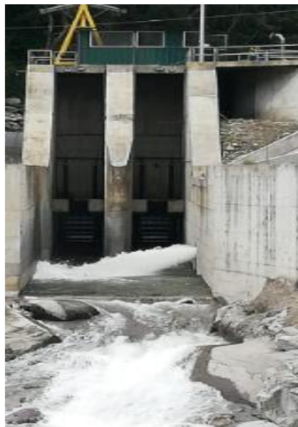
Figura 18. Desagües de fondo de agua.
