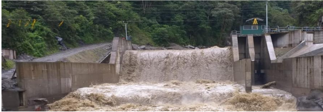
Figura 17. Vista frontal de azud en sistema de captación de agua de la central Río Verde Chico
