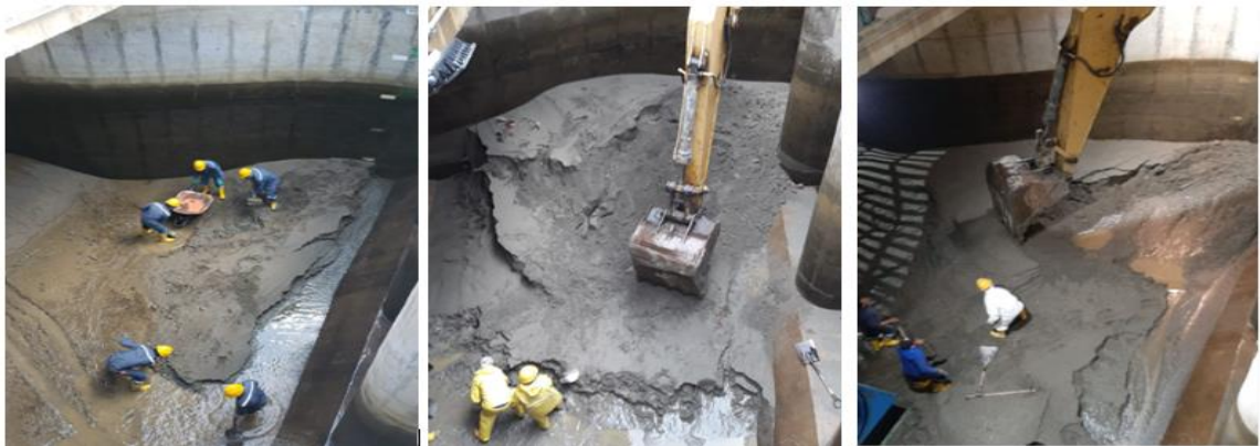
Figura 40. Limpieza de tanque desripiador por personal civil.
