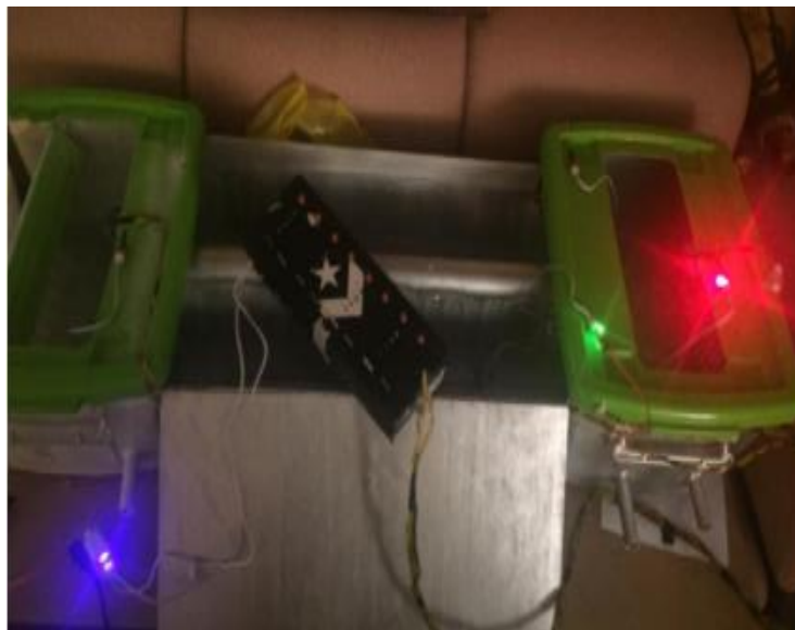
Figura 124. Prototipo en funcionamiento del sistema de monitoreo y control de compuertas de purga.
