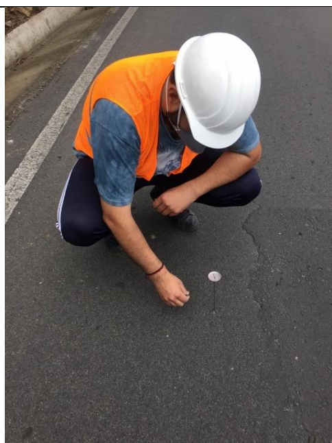
Fotografía 7: Medición de la temperatura en la capa de rodadura.
