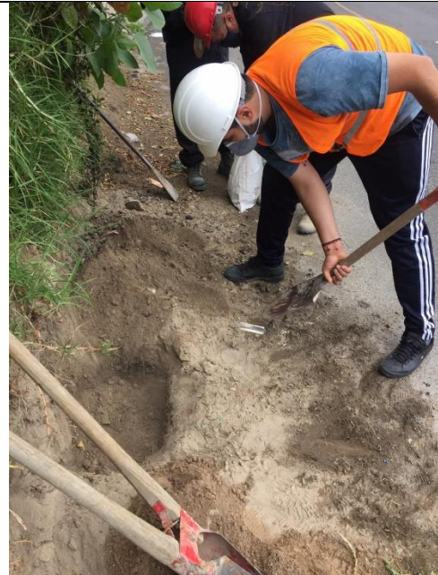
Fotografía 2: Ejecución de calicata para la obtención de la muestra de suelo.
